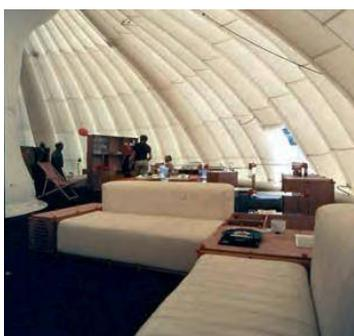
Cupola BBB, cupola pneumatica a struttura portante realizzata in occasione della 4 ° Eurodomus di Torino. Costolature e pilastro centrale in pressione, PVC calandrato e saldato (diametro esterno mt 18,8 altezza mt 7,60). All'interno un arredo completo per casa unifamiliare realizzato totalmente con il sistema Dado & Vite. De Pas, D'Urbino, Lomazzi, committente BBB Bonacina, esecutore Plasteco, 1972.
